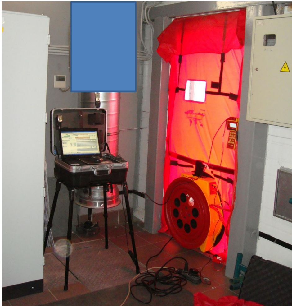
Фото установки оборудования в помещении №1.
