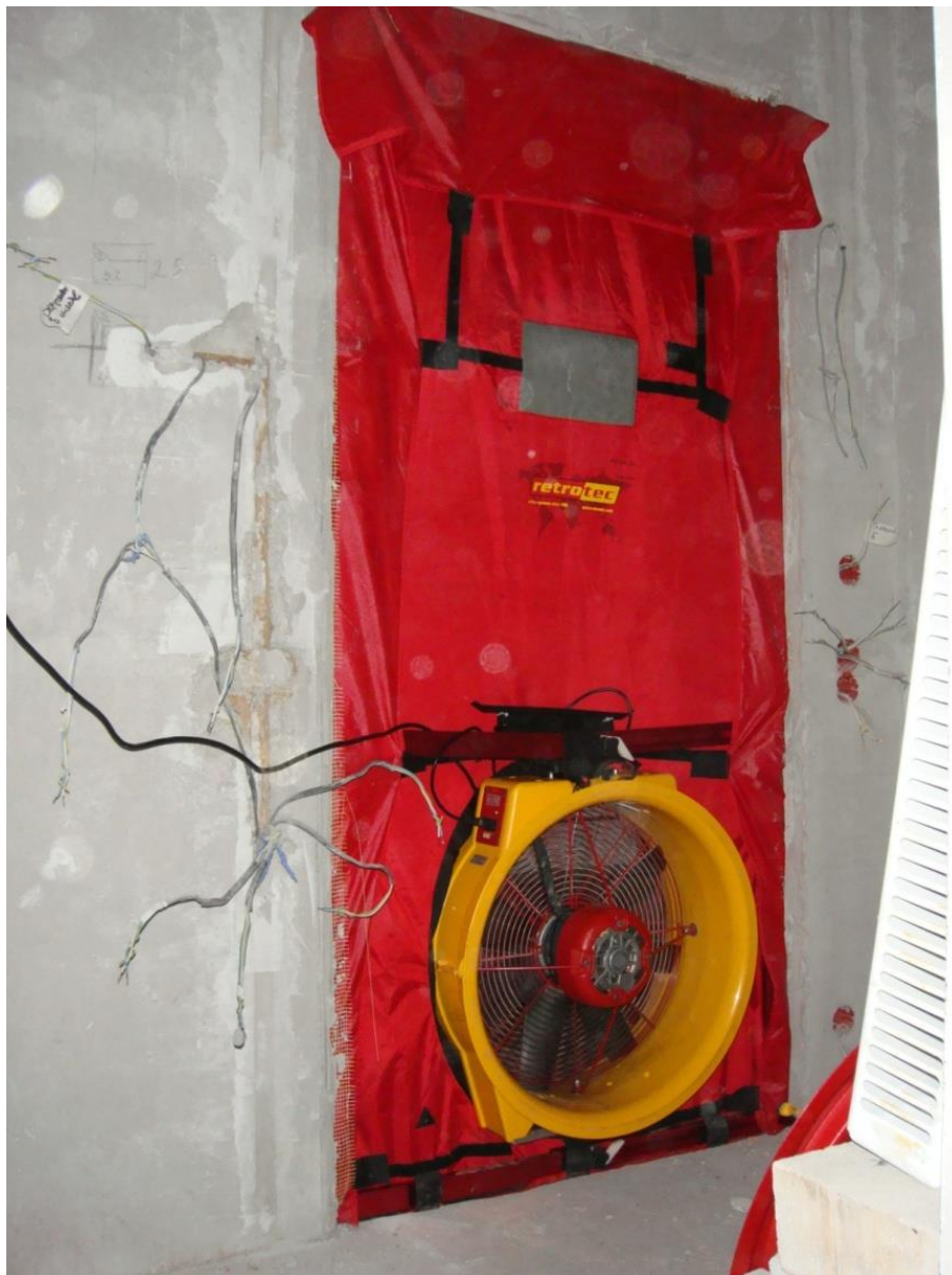
Фото установки аэродвери.
